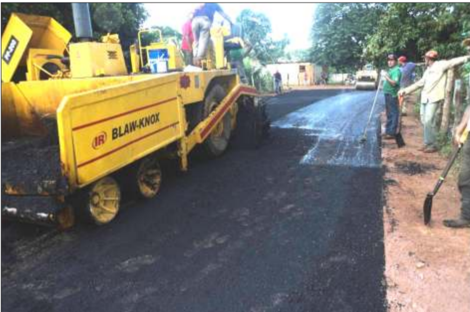
Los trabajos de asfaltado continúan Santa Rita de Manapire, municipio Las Mercedes del Llano.
