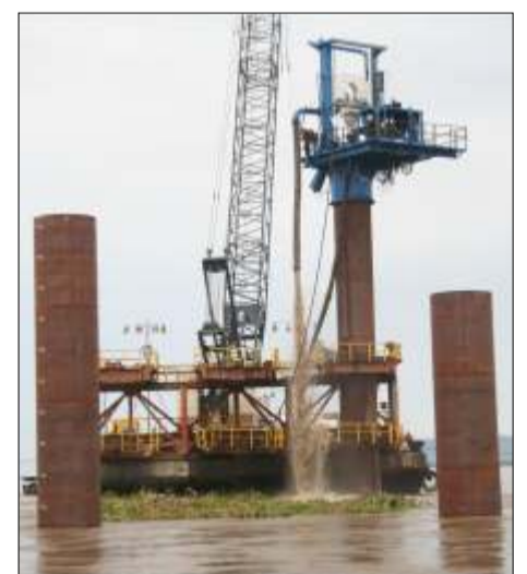
Proceso de Hincado y Perforación de Camisas en río
