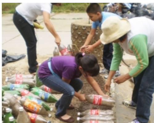
Distintas fases de la construcción de la pared con ladrillos “Ecológicos”.
