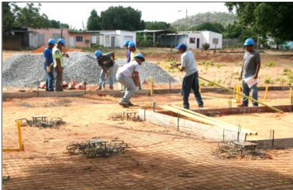
Vista general de la Construcción del Área de Servicios
