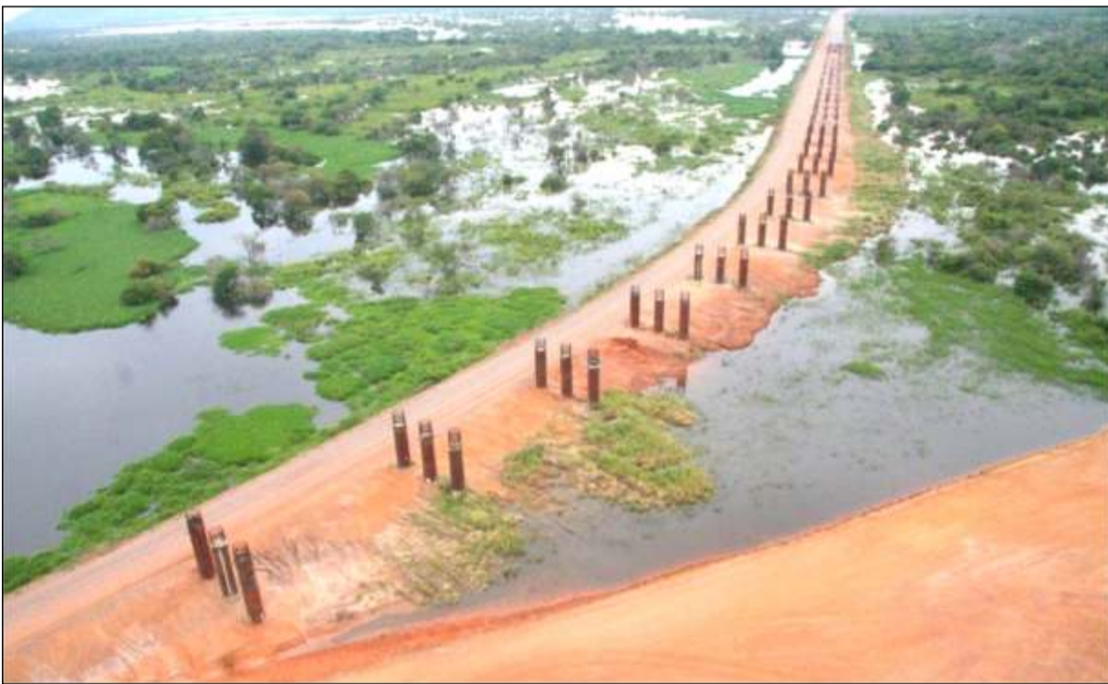
Vista General Terraplén Norte
