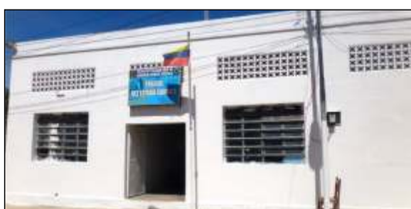
Rehabilitación del Módulo Policial de Cabruta
