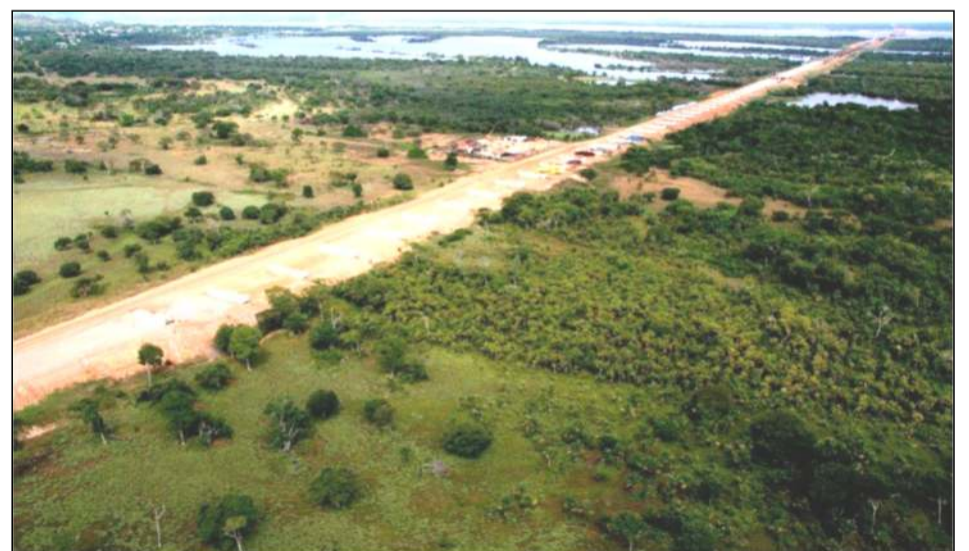
Vista General Terraplén Sur
