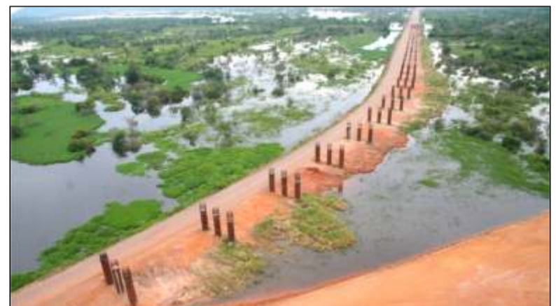
Vista General Terraplén Norte
