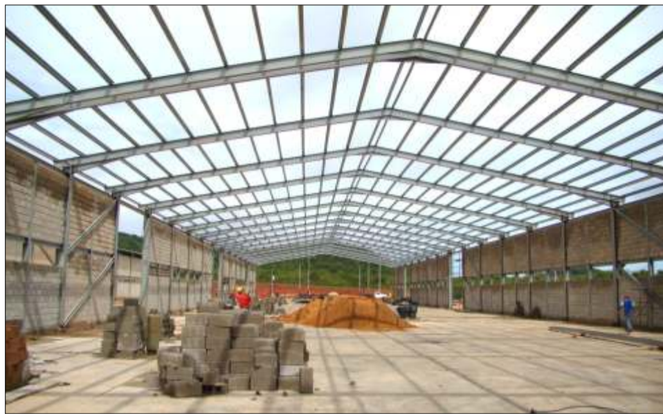
Inicio de la construcción de la Empresa de Propiedad Social Algodones del Orinoco
