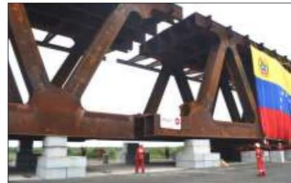
Vista de la colocación de posicionamiento de las piezas para su ensamblaje
