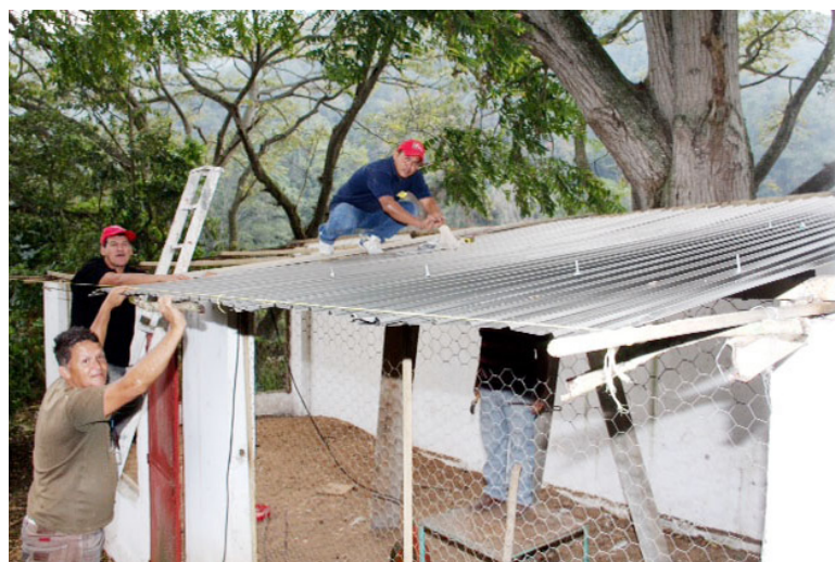
Sustituyeron el techo del galpón para gallinas ponedoras.
