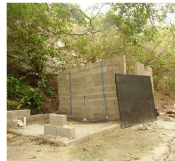
Foto 2 Baños en construcción se necesitan la mano de los entes para mejorar el servicio a esta población que está creciendo.
